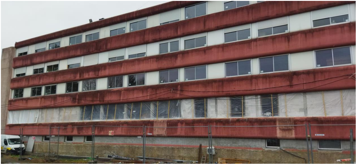
Façade actuelle des bâtiment (projet de réfection de façade non prévu initialement)
