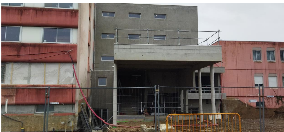
Nouveau bâtiment faisant la liaison entre les blocs existants (accès au hall en R+1)
