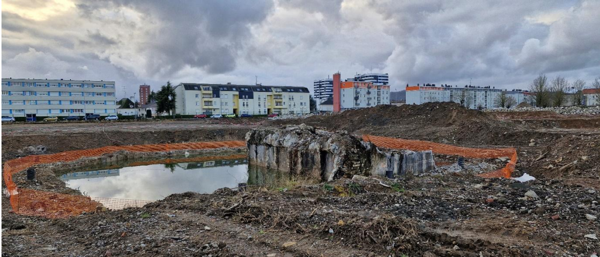
Photo n° 3 : Thionville - ZAC Rive Gauche : fondation de l'ancienne usine Etilam
