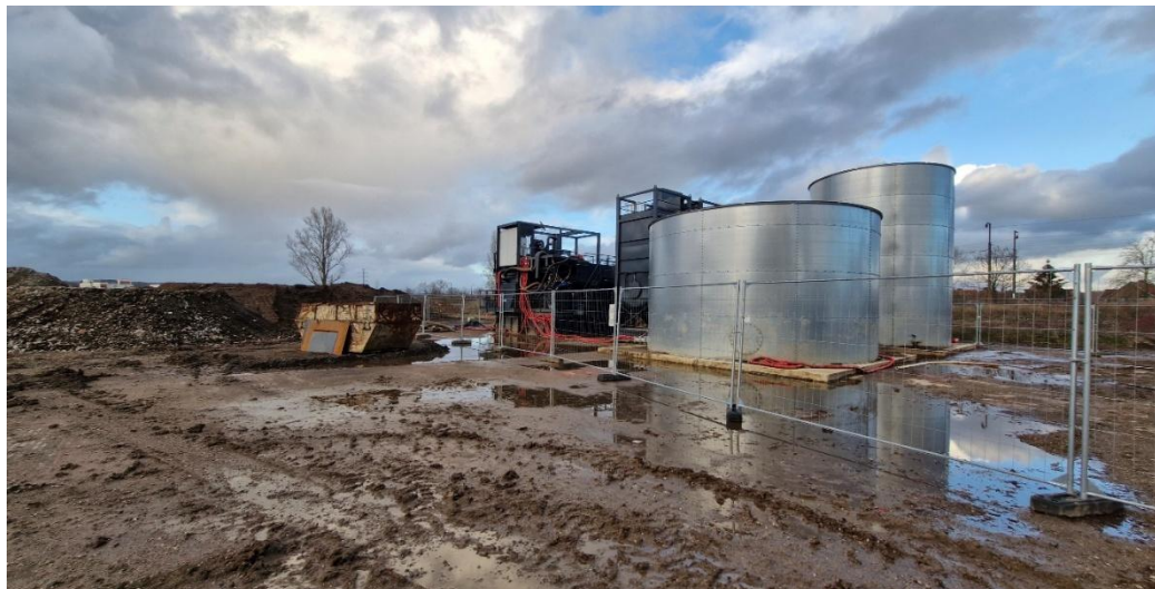
Photo n° 4 : ZAC Rive gauche Thionville : usine mobile de lavage des terres polluées
