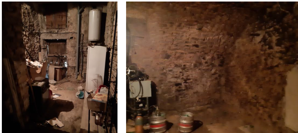
Photo n° 1 : État des caves du bar du Var au moment de l'achat
