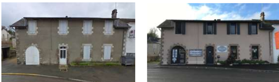
Photo n° 3 : Exemple de réalisation avec le fonds façades
