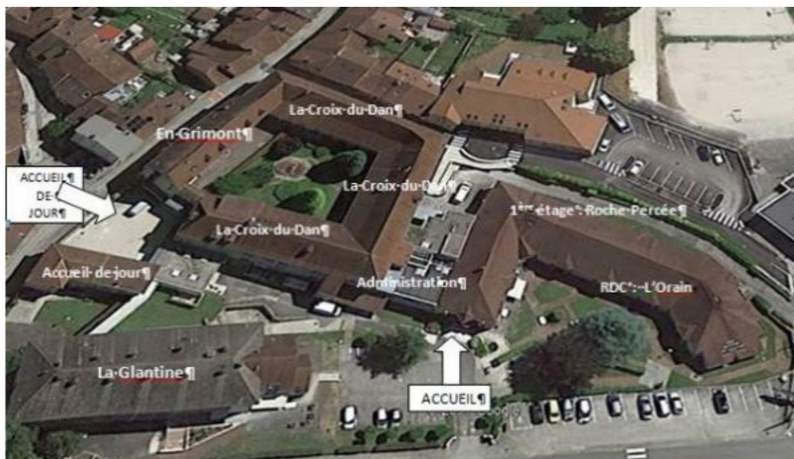
Photo n° 4 : Vue des bâtiments de l'Ehpad de Poligny
