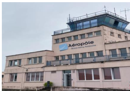
Photo n° 1 : Le bâtiment principal et la tour de contrôle
