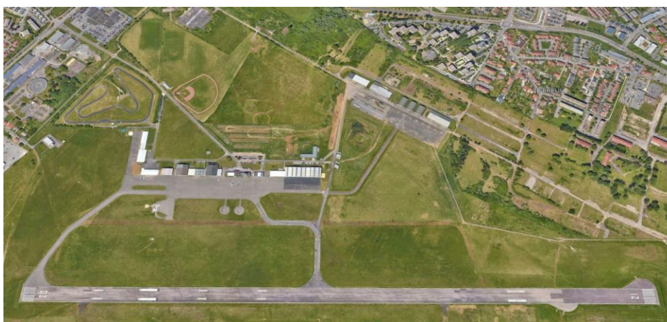
Photo n° 2 : Vue aérienne de la plateforme
