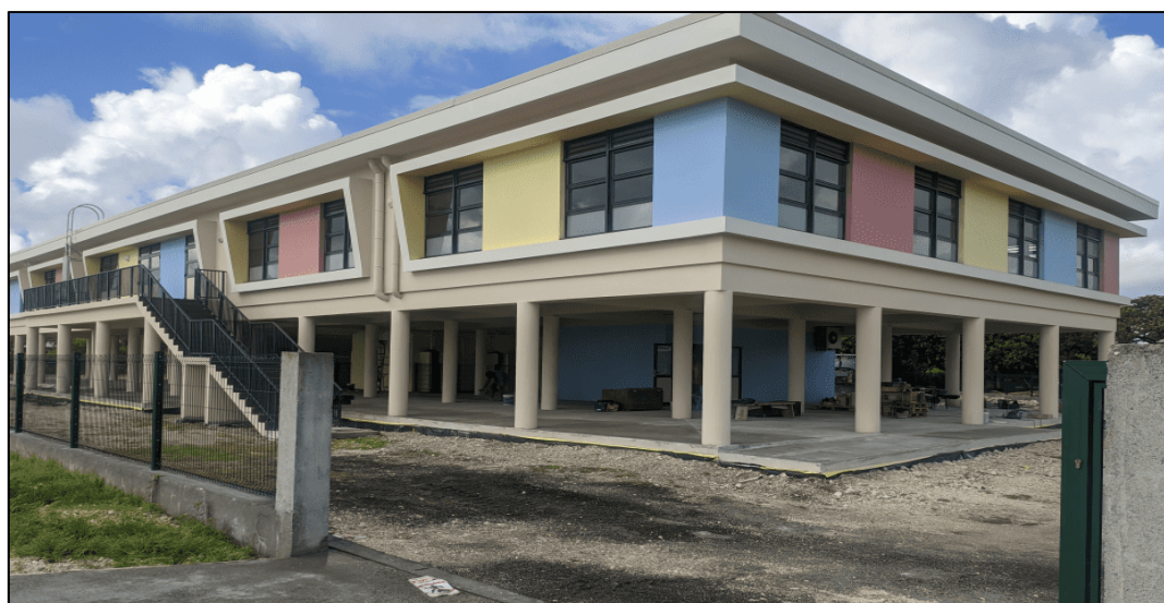
Photo n° 1 : École-abri de survie au stade des finitions
