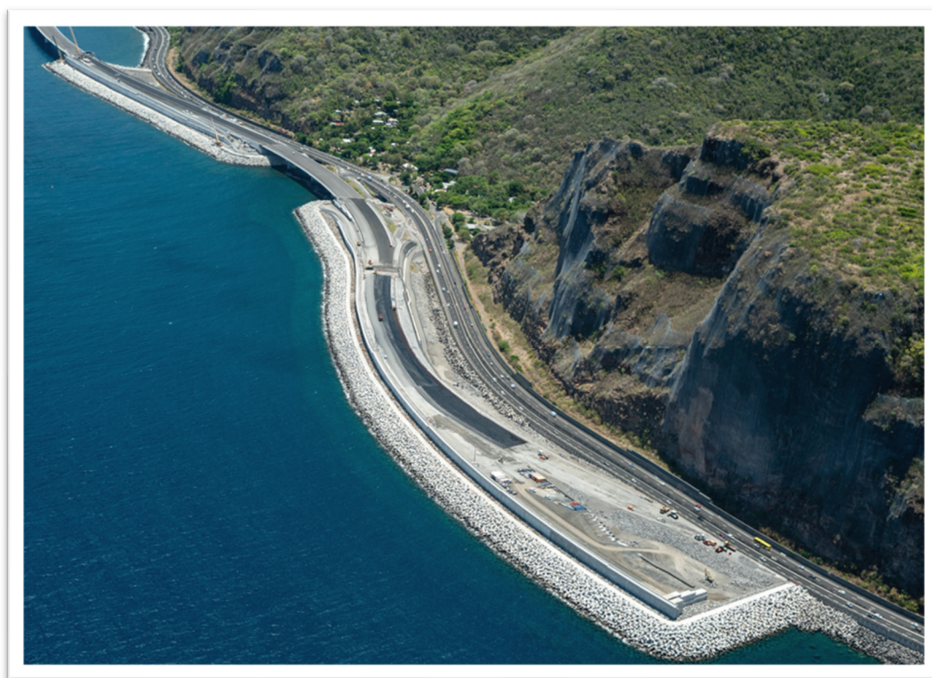
Photo n° 1 : Travaux de raccordement provisoire après le site de La Grande Chaloupe
