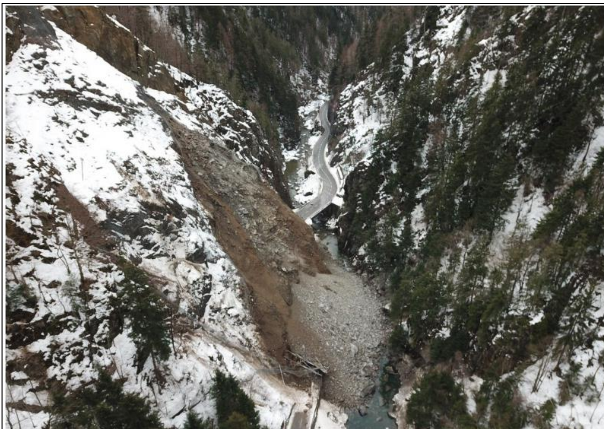
Illustration 4 : Vue de l'éboulement survenu en février 2019
