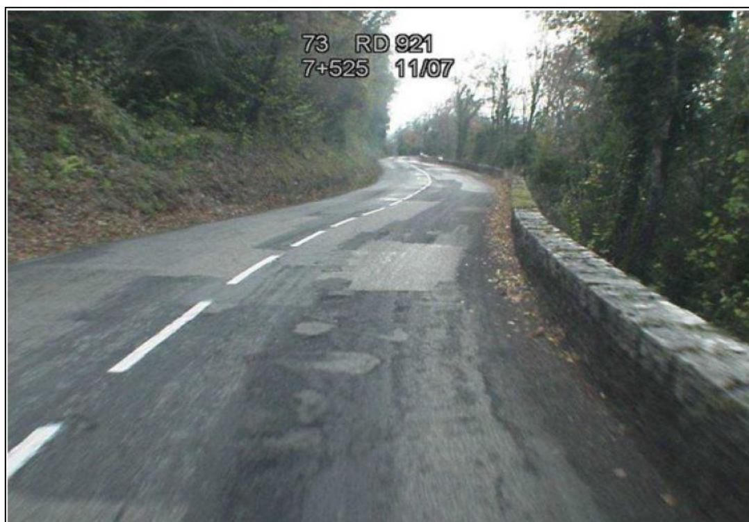
Illustration 2 : Prise de vue correspondant à une notation « mauvais état »
