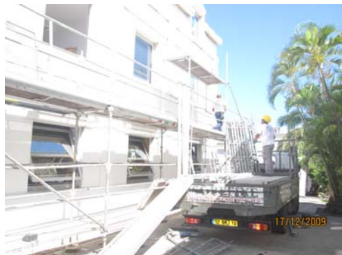
Réfection du bâtiment administratif principal en 2009
